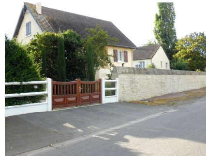
Mur en pierre construit en l'absence de mur existant
