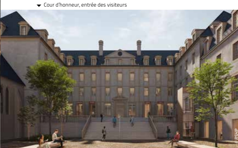
▼ Cour d'honneur, entrée des visiteurs
